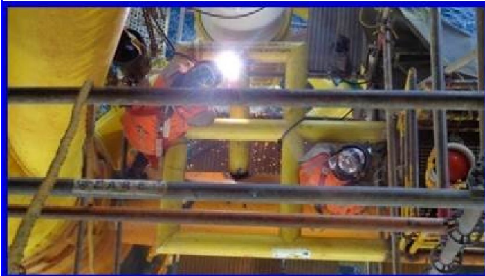
PDA. C.4 SE REALIZA APLICACIÓN DE SOLDADURA EN JUNTAS DE LA AMPLIACIÓN DE PASILLO DE SUBESTRUCTURA PARA TOMA DE LECTURAS DE POTENCIAL DE PLATAFORMA E-KU-A2. PLANO DE REFERENCIA D-OS012-G-018.
