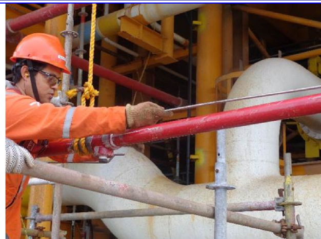
PDA. C.36 HABILITADO E INSTALACION DE RED DE TAPON FUSIBLE EN AREA DE TRAMPA DE DIABLO HR-1691, DE LA PLATAFORMA E-KU-A2
