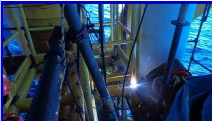
PDA. C.4 INSTALACIÓN CON APLICACIÓN DE SOLDADURA EN 05 PIEZAS DE BARANDALES DE LA AMPLIACIÓN DE PASILLO DE SUBESTRUCTURA PARA TOMA DE LECTURAS DE POTENCIAL DE PLATAFORMA E-KU-A2. PLANO DE REFERENCIA D-OS012-G-018.
