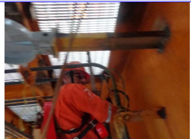
PDA. C.41 CIERRE DE TUBERIA CONDUIT HACIA SOPORTE DE LUMINARIA DEL SISTEMA DE ALUMBRADO NORMAL Y DE EMERGENCIA EN AREA DE CANASTILLA DE LA VÁLVULA SDV-1691 DE PLATAFORMA E-KU-A2.
