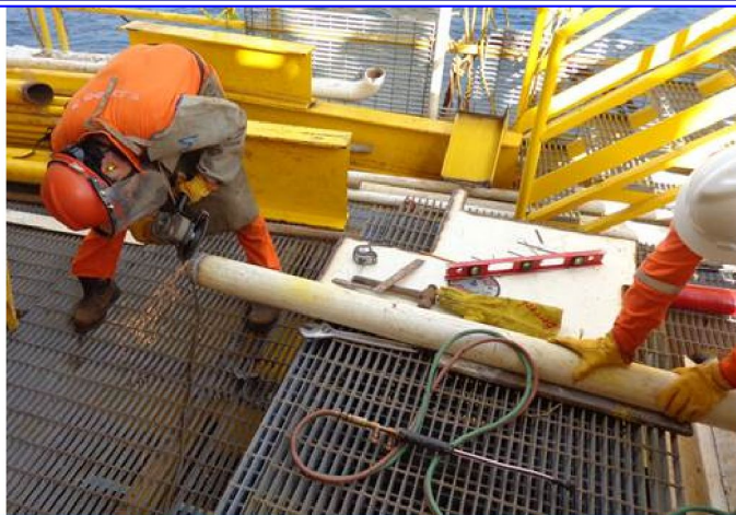
PDA. B.36 HABILITADO DE 01 SOPORTE ADICIONAL PARA VÁLVULA DE 3"Ø DE LINEA 3"-ACI-001-C-A11T1 DE LA RED DE AGUA CONTRA INCENDIO EN PLATAFORMA PB-KU-H.
