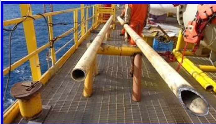
PDA. C.5 TRAZO, CORTE Y HABILITADO DE BISELES DE 02 PERFILES ESTRUCTURALES TIPO OC DE 4"Ø PARA CONTRAVÉNTOS A INSTALARSE EN LA PLATAFORMA PARA OPERACIÓN DE VÁLVULA SDV-1691; DE ACUERDO A PROPUESTA TD3007-DR-TS-93045-1.
